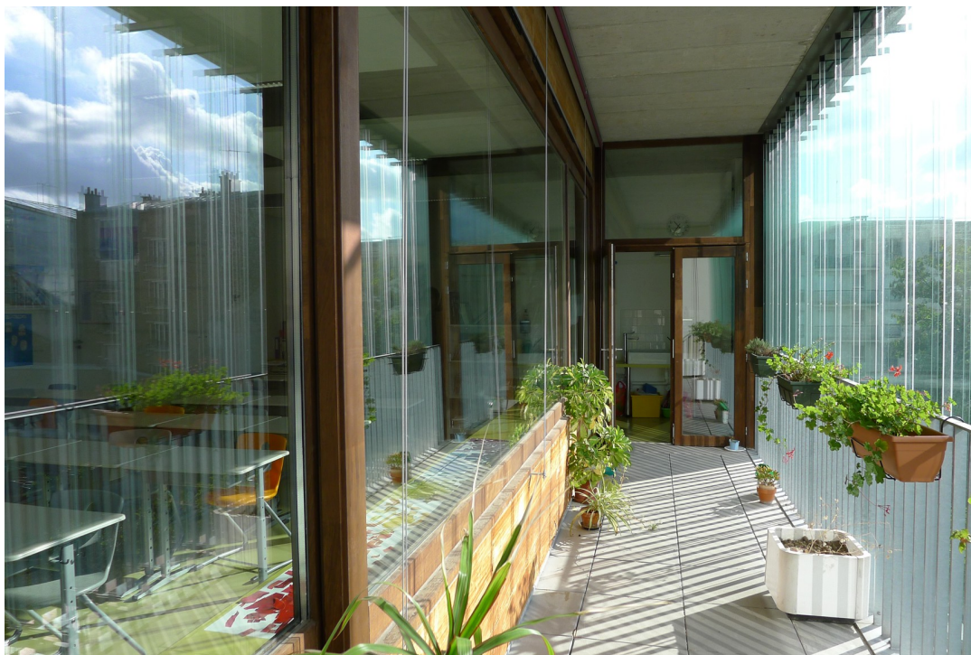
Chaque classe de cette école bénéficie d'une loggia assurant le double rôle de préchauffage de l'air entrant et d'espace pédagogique individualisé (© C. Rigot/URCAUE)
