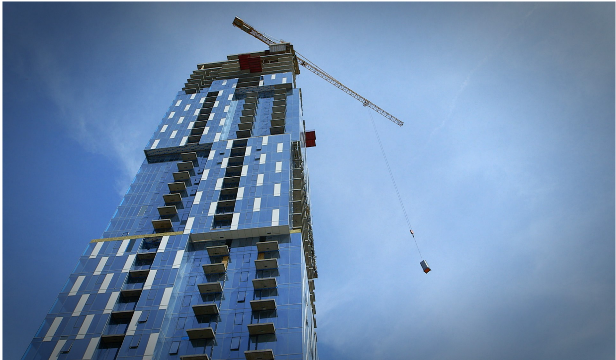
Immeuble quelconque typique du développement actuel à Montréal ( Main basse sur la ville © Films de l'Œil).
